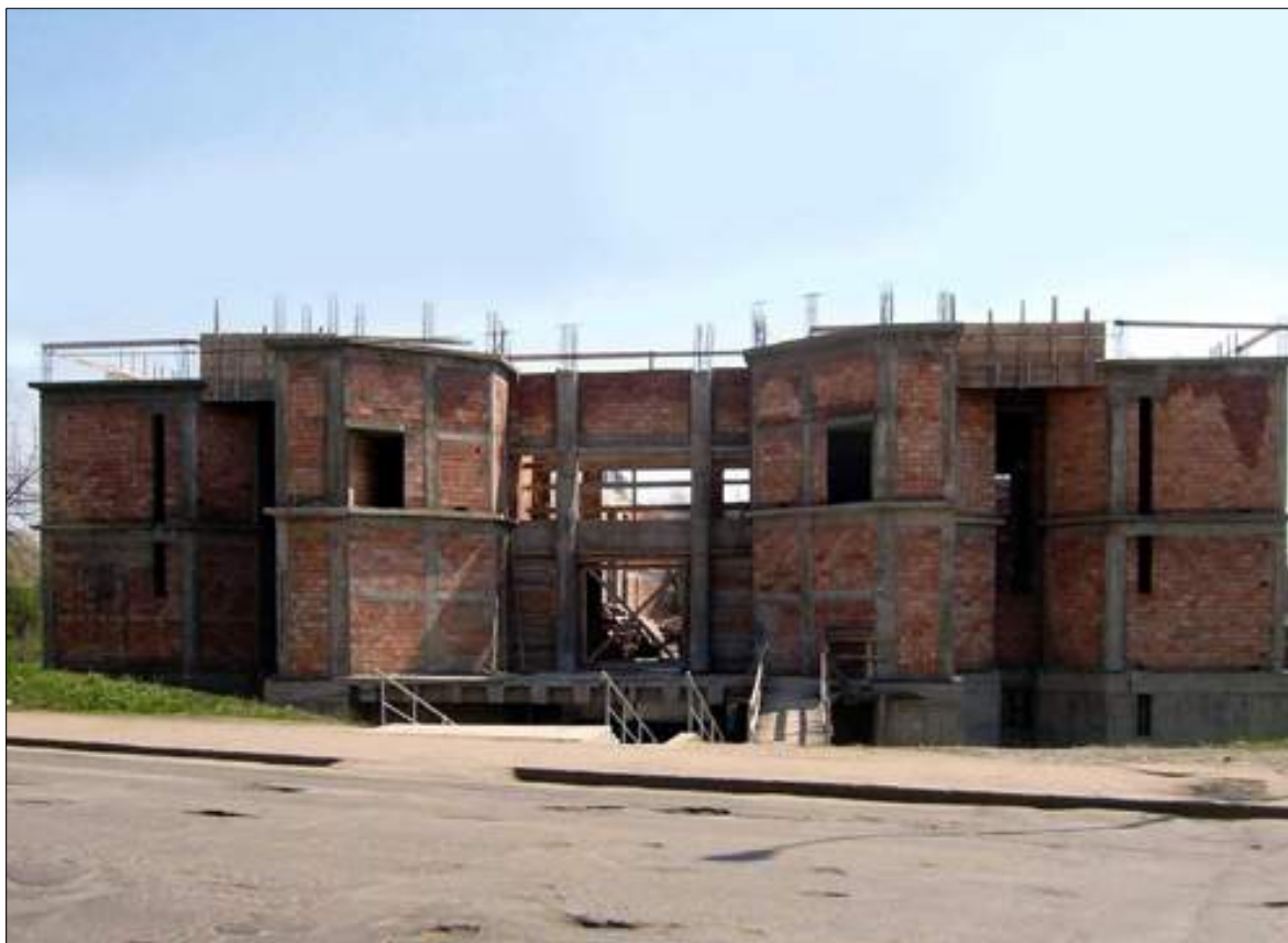
Épülő templom a Golescu híd hídfőjénél
