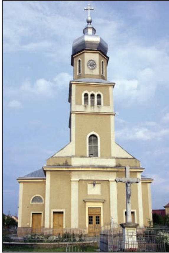
A csanálosi római katolikus templomot Tischler Albin tervein alapján építették át, bővítették ki.
